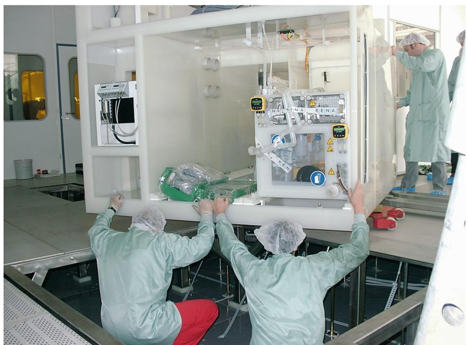
Fig. 2: Einbringung der Reinigungsbank in den Reinraum des IIS-B; Bringing in the final clean wet bench into the cleanroom of IIS-B.
