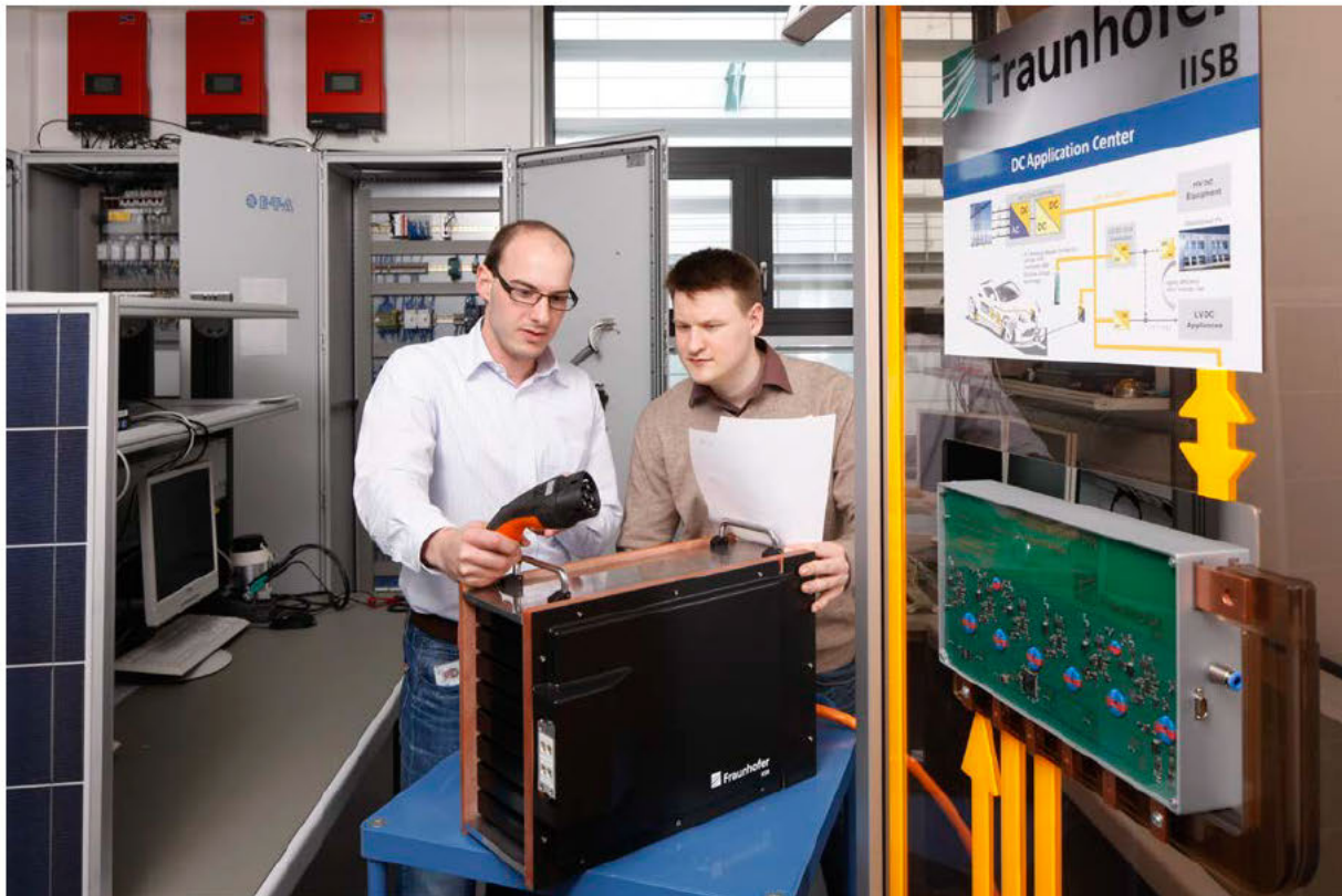
Michael Steinberger und Philipp Puls im DC-Labor des Fraunhofer IISB in Erlangen. Im Rahmen des Projekts SEEDs werden dort u.a. lokale Gleichstromnetze mit solarer Einspeisung und integrierten elektrischen Speichern unter Nutzung bidirektionaler DC/DC-Wandler erforscht und erprobt. Bild: Fraunhofer IISB / Kurt Fuchs
