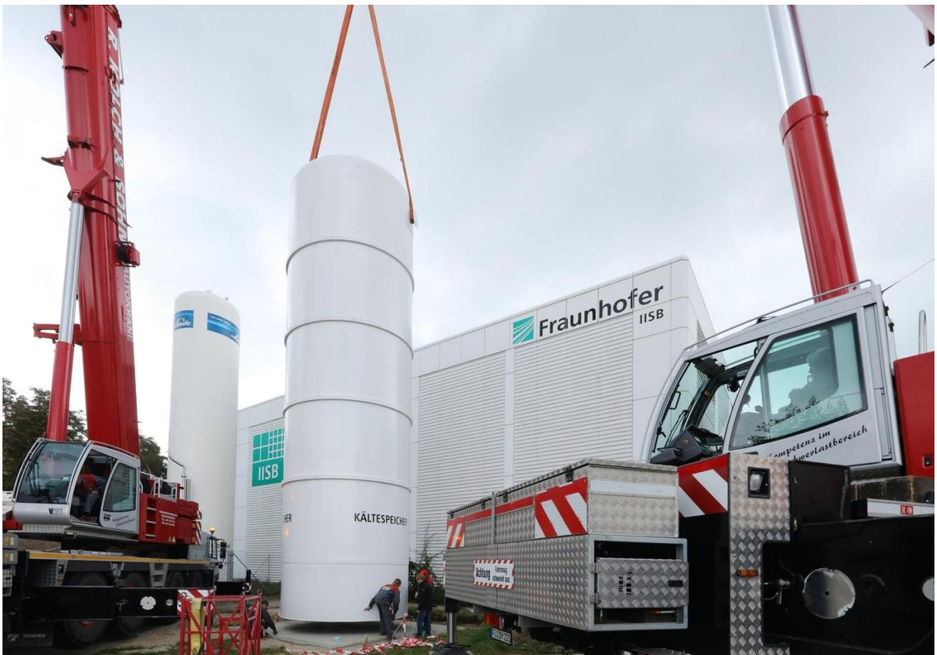
Am IISB wurde ein in seiner Größenklasse weltweit einmaliger Kaltwasserspeicher mit Vakuumisolation installiert. Mit einem Ladevolumen von 80 Kubikmetern ist die Spezialanfertigung der Firma Sirch aus Kaufbeuren besonders für industrielle Anwendungen interessant. Der vakuumisolierte Kaltwasserspeicher wird im Rahmen des bayerischen Energieforschungsprojektes SEEDs eingesetzt, um die Effizienz der Kaltwasserversorgung für die Kühlung der umfangreichen Prozessanlagen und Labore am IISB zu erhöhen.
