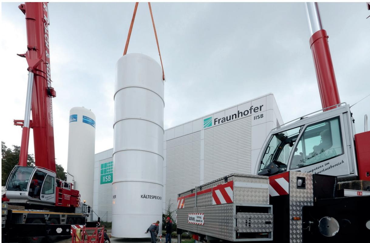
*Aufstellung des vakuumisolierten Kaltwasserspeichers vor dem Reinraumlabor am Fraunhofer IISB in Erlangen am 11.10.2016. Der Speicher ist in seiner Größenklasse derzeit weltweit einmalig und dient der Optimierung der Kälteinfrastruktur. Bild: Kurt Fuchs / Fraunhofer IISB*
