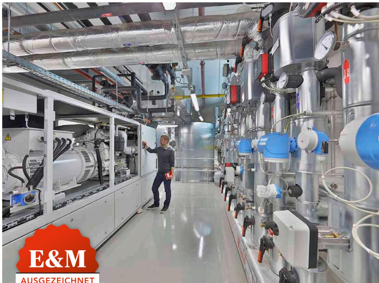
Blockheizkraftwerk und Warmwasserspeicher im Keller des Fraunhofer IISB: Die Kraft-Wärme-Kopplungsanlage wurde im Rahmen des Erweiterungsbaus B in die Infrastruktur des Instituts integriert. Dort wird sie sowohl zur Wärme- und Stromversorgung als auch zu Forschungszwecken genutzt
